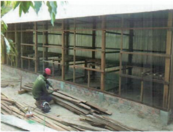
ទ្រុងមានគ្រោងជាបួស្សីដំបូលស្លឹក និងមានកម្រាលអង្កាមកម្ពស់៥ទៅ១០សម។ ទ្រុងនេះត្រូវបានបែងចែកទៅតាមទំហំផលិតកម្ម។
