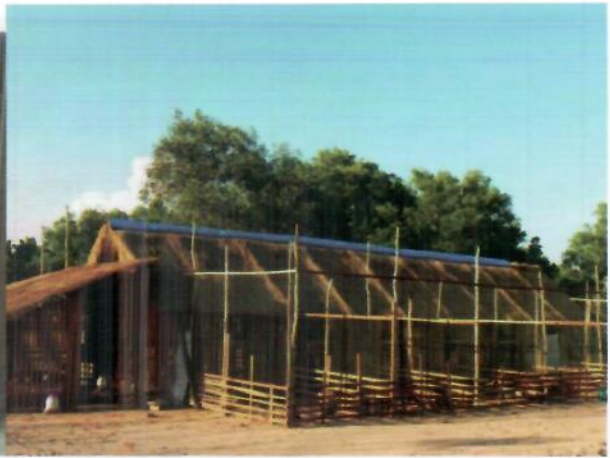
ទ្រុងមានគ្រោងជាបួស្សីដំបូលស្លឹក និងមានកម្រាលអង្កាមកម្ពស់៥ទៅ១០សម។ ទ្រុងនេះត្រូវបានបែងចែកទៅតាមទំហំផលិតកម្ម។
