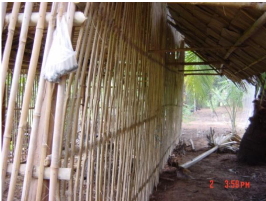
រូបភាព ៦ រនាបឬស្សីអាចប្រើប្រាស់ក្នុងការធ្វើរបង បង្ហាងផងដែរ ។
